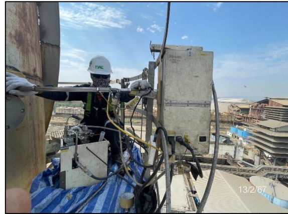
ปล่องหม้อไอน้ำ Boiler 60 ตัน กรณีพ่นเขม่า (Soot Blow)
